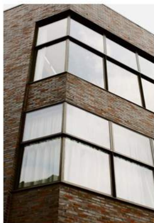
De geknikte stalen ramen halen maximaal zonlicht naar binnen.
